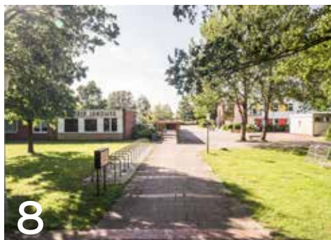
8 Blick auf die Schule Mittlerer Landweg
