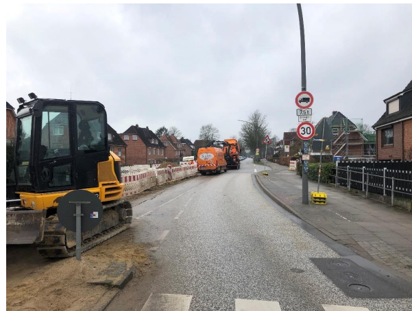
Abbildung 13: Baustelle Nettleburger Straße / Randersweide (Quelle: eigene Aufnahme): wenige Flächen während Baustellen, potenzielle Gefahrenstellen.
