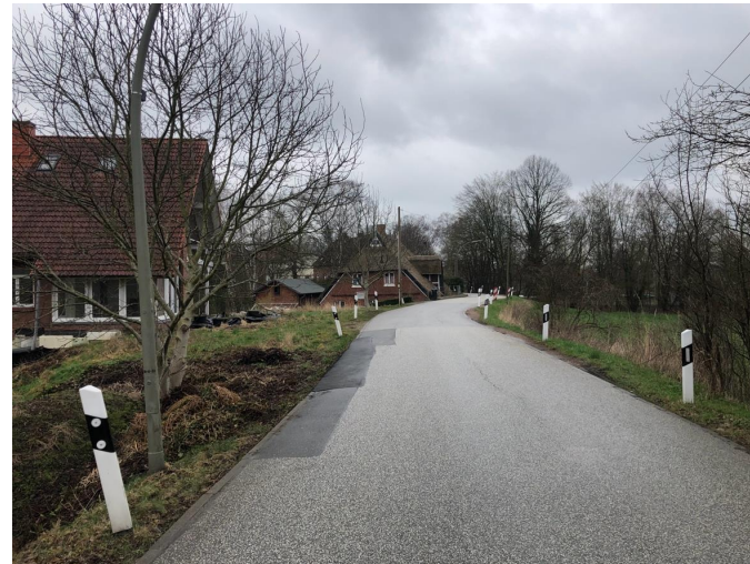
Abbildung 9: Straße Kurfürstendeich (Quelle: eigene Aufnahme), keine Fuß- und Radverkehrsanlagen, gute Fahrbahnoberfläche, leicht abschüssig an den Fahrbahnrandern.
