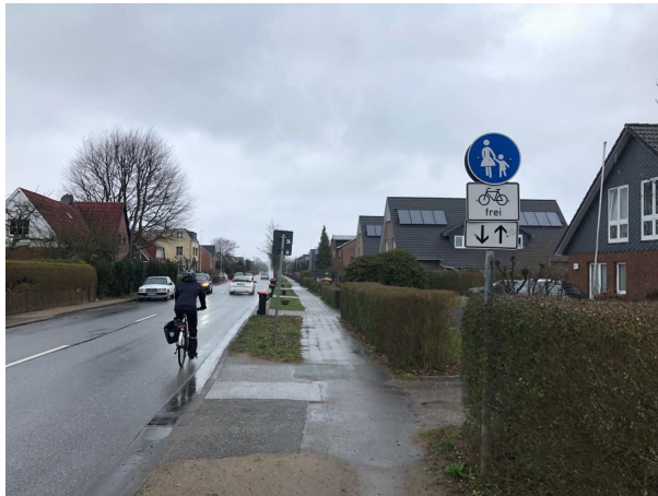
Abbildung 20: Radwegsituation Curslackter Heerweg (Quelle: eigene Aufnahme), schlechte Oberflächenqualität Fußwege, schmale Fußwege, schmale Fahrbahn, kein separater Radweg.
