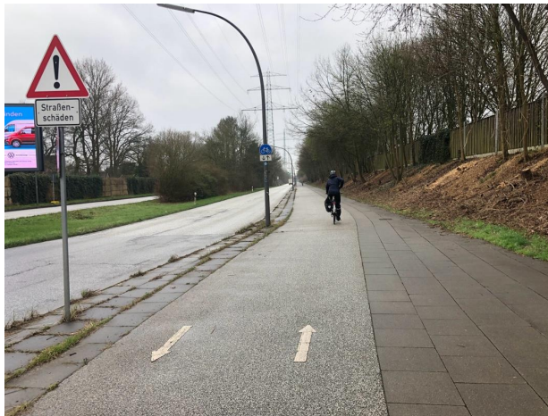
Abbildung 10: Straße mit Rad- und Fußweg Nettlenburger Landweg (Quelle: eigene Aufnahme), gute Fahrbahnqualität, bei hohem Radverkehrsaufkommen: zu geringe Dimensionierung des Zweirichtungsradweges.
