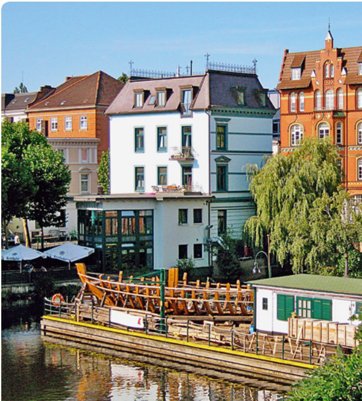
Abb 3-31: Bergedorfer Hafen / Bau des Vierländer Ewer
