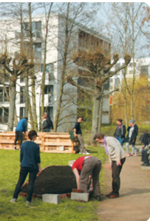
Abb. 3-30: Schillergarten im Entstehen
