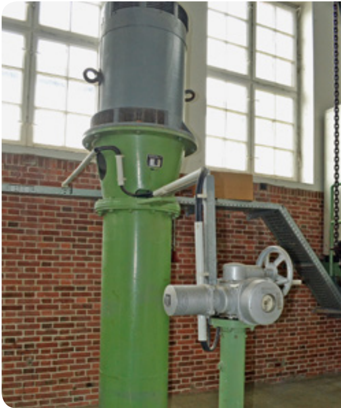
Abb. 3-3: Vertikale Schöpfwerkpumpe
